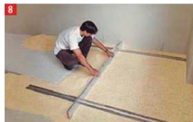
Von der Tür aus Abdeck- bzw. Trittschalldämmplatten auslegen. Dämmplatten untereinander dicht stoßen, Kreuzfugen vermeiden. Empfehlenswert sind Trittschalldämmplatten mit einer dynamischen Steifigkeit von 20 – 40 MN/m<sup>3</sup>.
