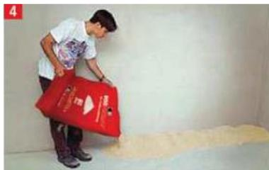
An der Wand BISOTHERM Bio Trockenschüttung in ca. 20 cm Breite auf Höhe des Markierungsstriches aufschütten. Falls erforderlich (Feuchtraum, Keller, Garage) unter der Trockenschüttung eine Dampfsperre einbauen.
