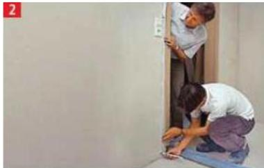
Vom Meterriss 1 m + Fußbodenaufbau hinuntermessen (z.B. Belag 5 mm, Spanplatte 22 mm, Abdeckplatte 8 mm) = 1,035 m.
