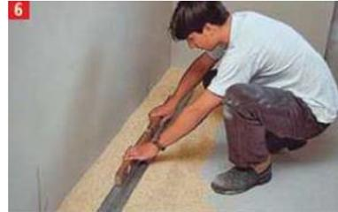
Auf dem Wandstreifen wird die Auflegelehre mit der Wasserwaage ausgerichtet. Im Abstand der Abziehle (ca. 10 – 20 cm weniger) wird ein weiterer Streifen aus BISOTHERM Bio Trockenschüttung geschüttet, die zweite Auflegelehre aufgelegt und mit der Abziehle und Wasserwaage ausgerichtet.
