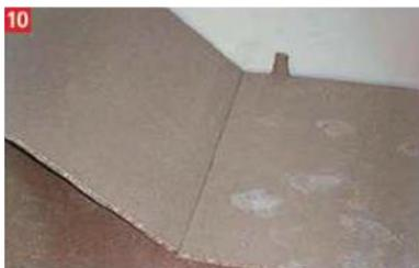
Nachdem die Abdeckplatten oder die Schaltafeln aufgelegt wurden, kann mit einem Handstampfer oder einem leichten Flächenrüttler verdichtet werden.
