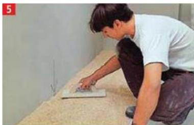
Mit dem Reibebrett / der Glättkelle wird die Trockenschüttung auf die Höhe des Markierungsstriches gebracht.
