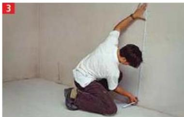
Höhendifferenz zur Rohdecke bzw. alten Dielenboden ermitteln (z.B. Höhendifferenz 5 cm, Schütthöhe 5,5 cm, Maß vom Meterriss 1,03 m), Maß an der Wand markieren. Falls erforderlich verlegen Sie auch eine Dampfsperre und einen Randstellstreifen.
