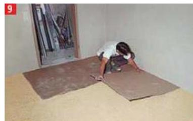
Der weitere Aufbau, wie in den Anwendungsbeispielen angegeben mit z.B. Trockenestrich oder Spanplatten nach Herstellerangaben verlegen. Dabei min. 1 cm Abstand von der Wand einhalten.
