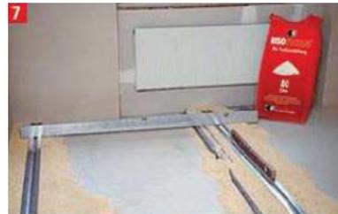
Vom hinteren Ende des Raumes zur Tür hin über die Auflegelehren die Trockenschüttung abziehen. Vor dem Abziehen kann die Trockenschüttung bereits leicht verdichtet werden. Installationsleitungen sollten mit min. 12 mm überdeckt werden (dreifaches Größtkorn).
